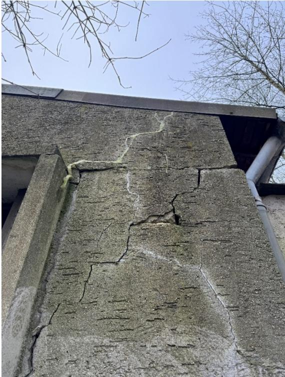
Massive Schädigungen der tragenden Außenwände
