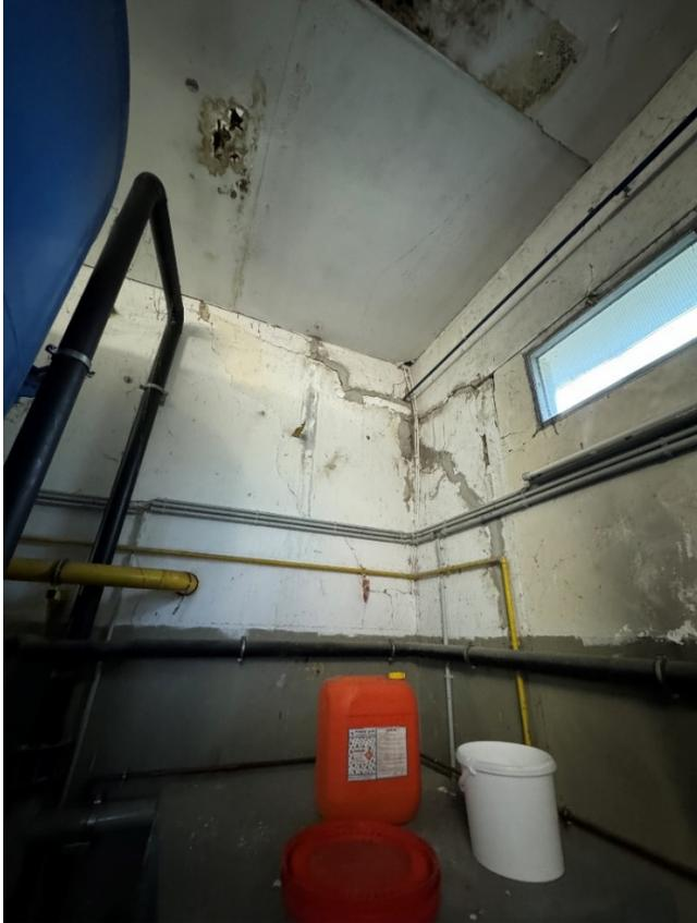
Feuchtigkeitseinträge durch Dachkonstruktion und Wände.
